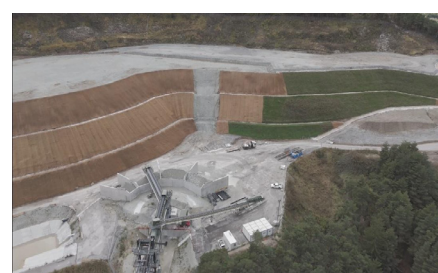
Zone des Tièrces, Villarodin-Bourget, octobre 2024 : verdissement sur fibre végétale pour l'intégration paysagère.
