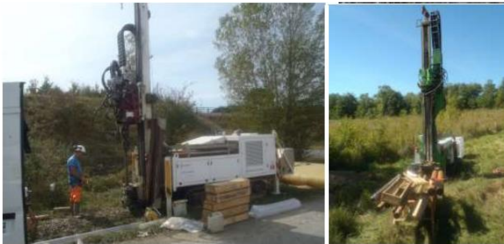
Figure 1 : Exemple de machine utilisée dans le cas de sondage carotté, à la tarière, ou pressiométrique
